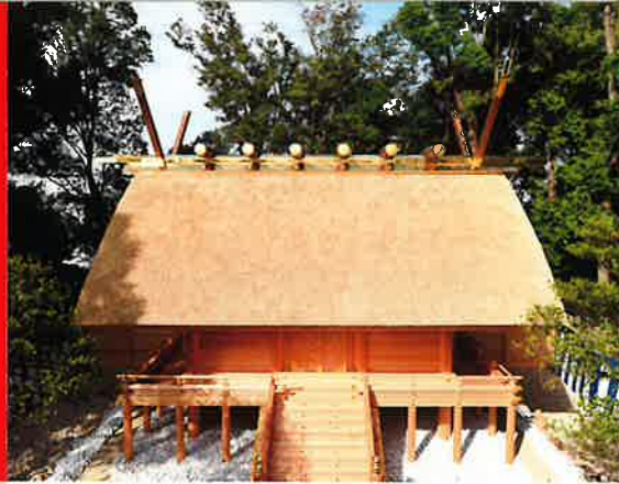
現本殿（平成 30 年竣功）
