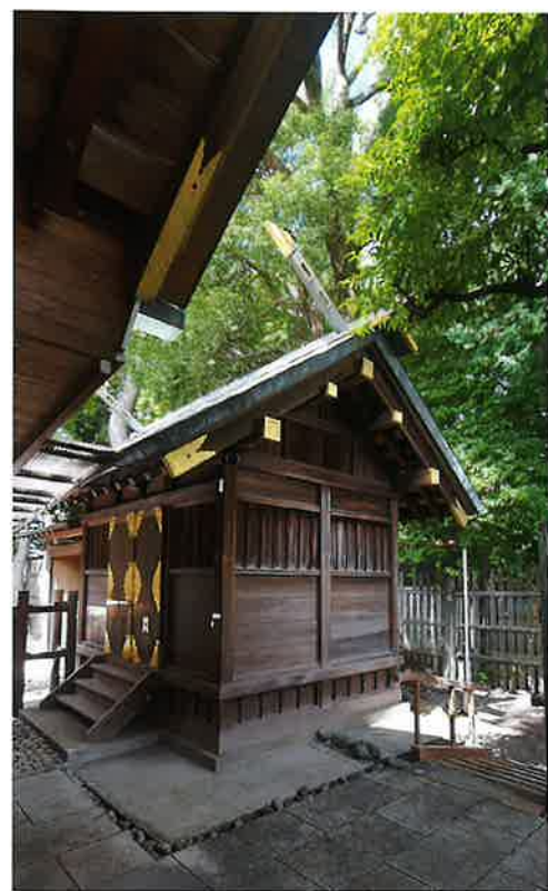
神饌所 昭和2年竣工、設計・遠藤於菟、施工・清水組 拝殿と共に歩む復興社殿の貴重な一棟である。
