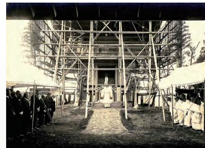
関東大震災で焼失した社殿再建の上棟祭を斎行(昭和2年)
